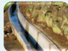
コンクリート水路の更新
