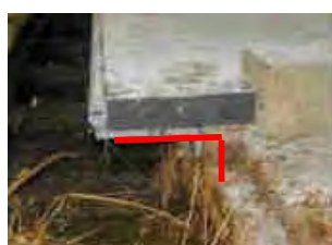
つなぎ牛舎の改良
