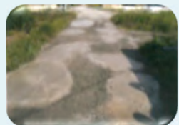
農道の窪みの補修
