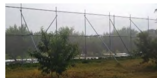
防風ネットの設置
