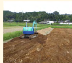
土層改良（客土）
