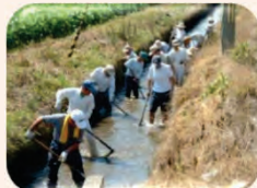
水路の泥上げ
