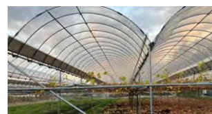
簡易雨よけ設備
