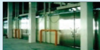
大型加工施設の整備
