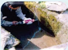
水路のひび割れ補修
