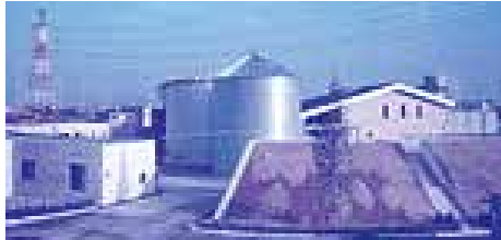
バイオマス発電設備 (福岡県大木町) (おおき循環センターくるるん)
