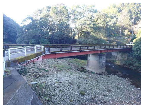
橋梁補修箇所
