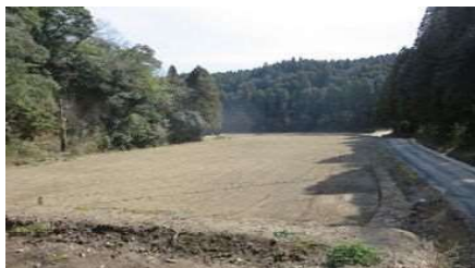
区画整理工事が完了したほ場
