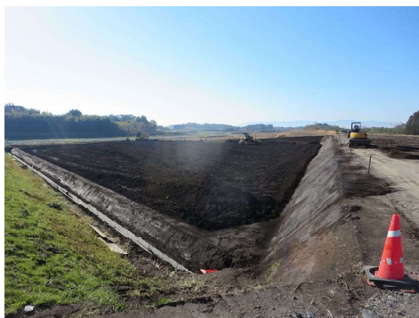
区画整理工事の様子
