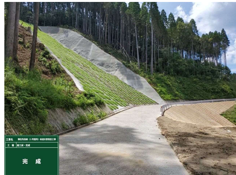
林道災害 復旧完了
