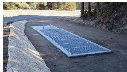
事業で整備した取水施設
