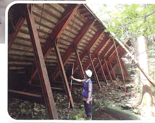
▶治山施設の点検
