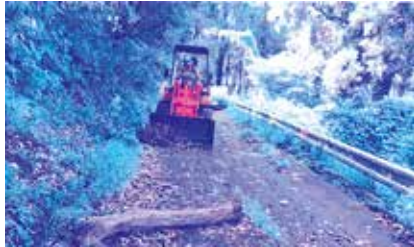
林道の災害復旧作業
