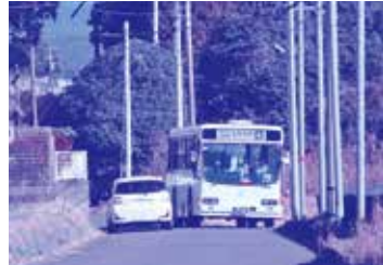
県道柿ノ木・志布志線の状況
