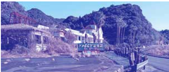
国道沿いの廃墟の状況
