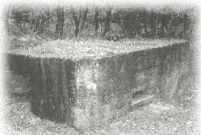
押切のトーチカ跡
