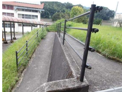
スロープ・手すり
