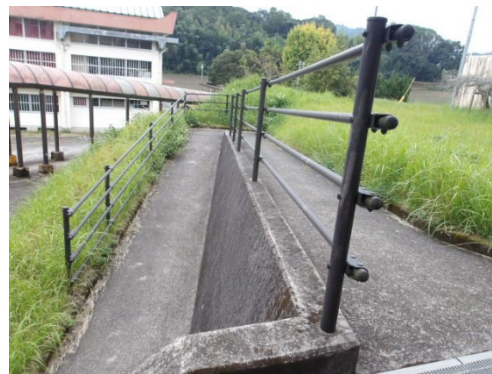
スロープ・手すり
