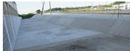
メンテナンスフリー工事実施状況
