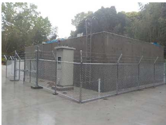
更新された坪山配水池
