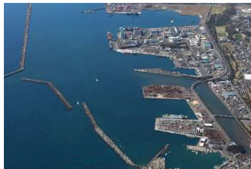
志布志港の全景
