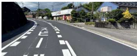
道路整備（舗装）実施状況
