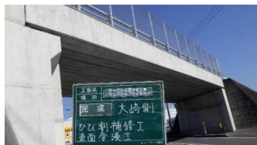
稚子松跨道橋 補修後
