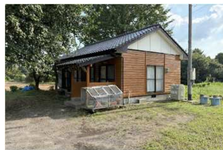
修繕後の自治会集会施設
