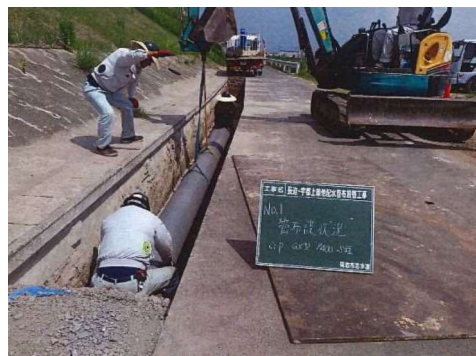
新たに布設した水道管
