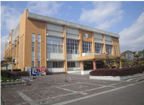
屋根防水改修を実施予定の 城山総合運動公園体育館
