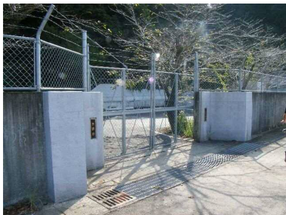
大迫第1水源地
