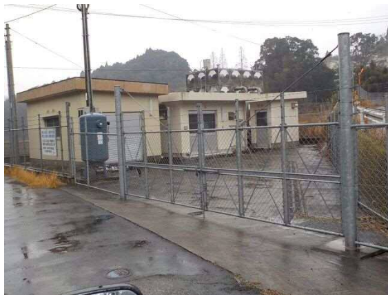
久保園送水ポンプ場
