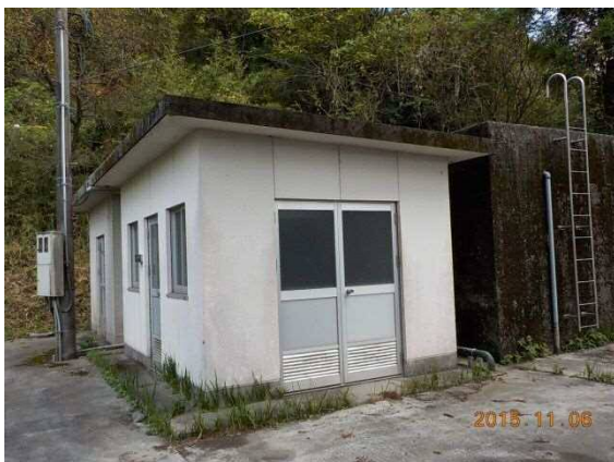
十文字中継ポンプ場（ポンプ槽）
