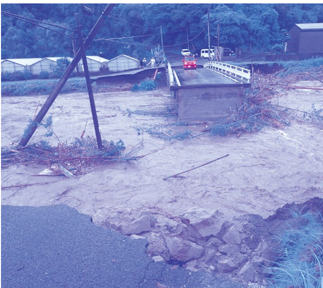
濁流により落橋した市道東原・立本線の上畑橋
