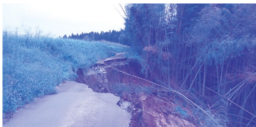
大きく崩落した農道
