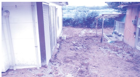
民家への土砂流入
