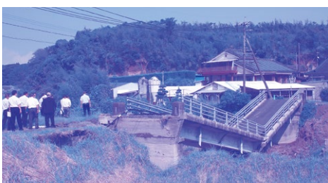
市道中組線「本宮橋」の現地確認
