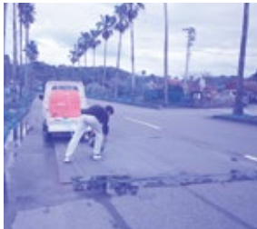
志布志港周辺での日2回のマット洗浄作業
