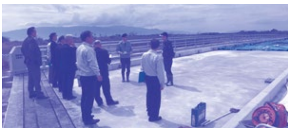
市道香月線（工業団地横新設橋梁）の現地確認
