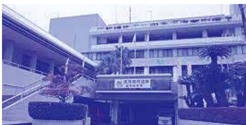
市役所志布支所
