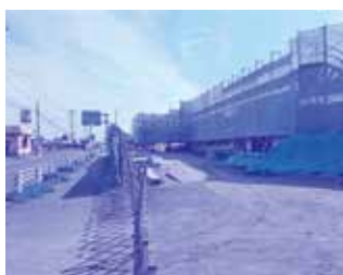
建設中の救急クリニック
