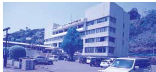
志布志支所庁舎
