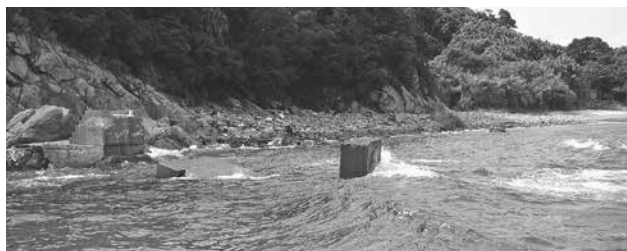
破損している枇榔島橋
