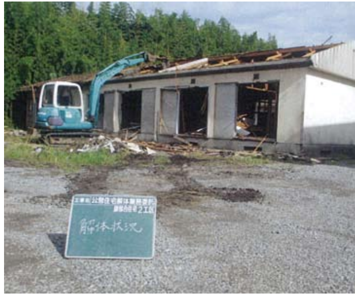
市営住宅解体工事
