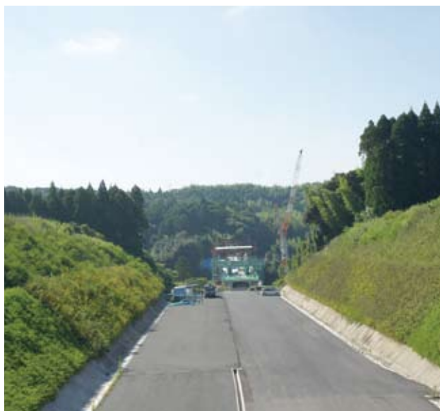
建設中の都城志布志道路
