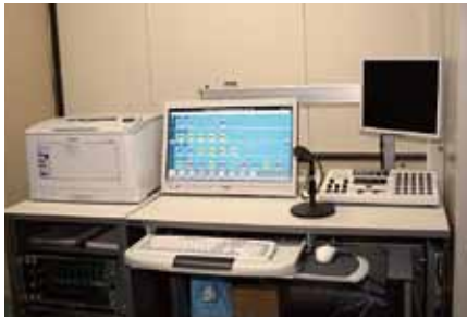
防災行政無線デジタル操作卓
