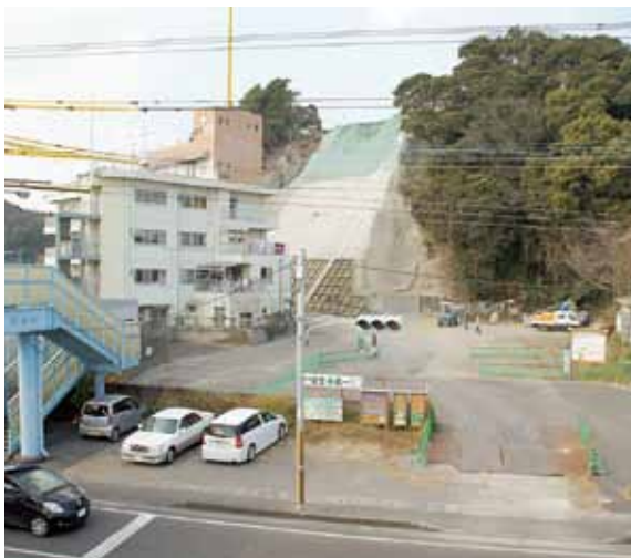
市道改良工事
