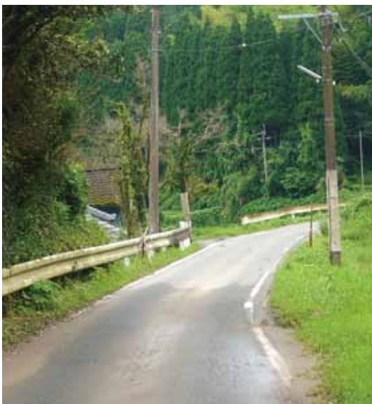
県道設置の防犯灯
