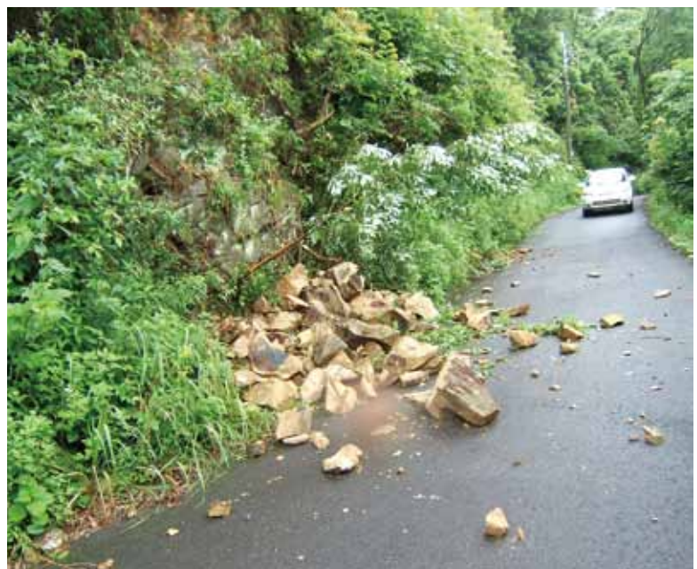
林道陣岳支線の崩落現場
