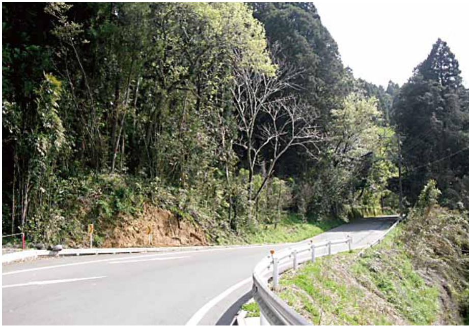
弓場ヶ尾・佐野原線改良工事の予定箇所
