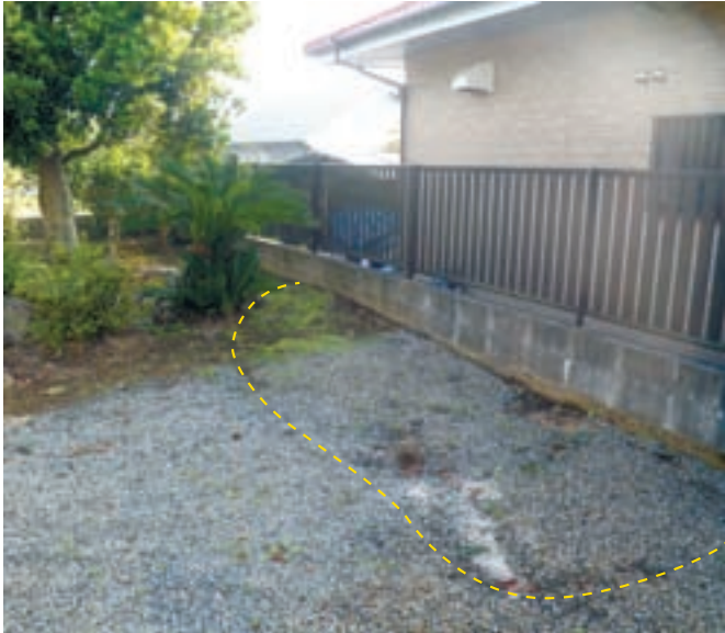
住宅地の陥没状況
