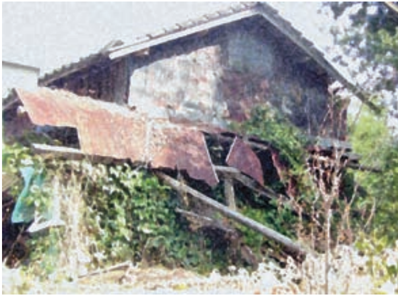
解体望まれる危険廃屋
