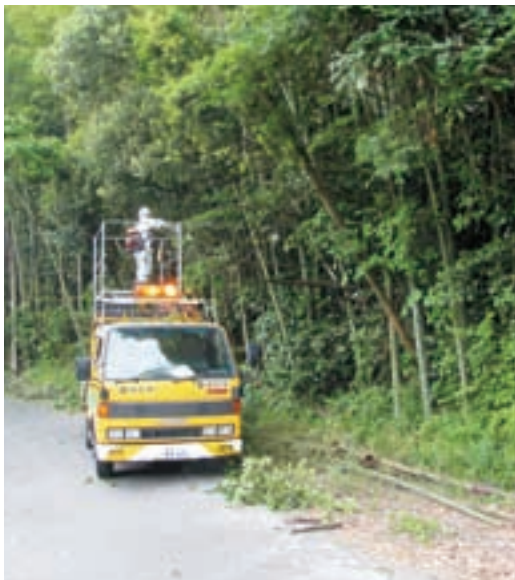
市道の高所伐採作業
