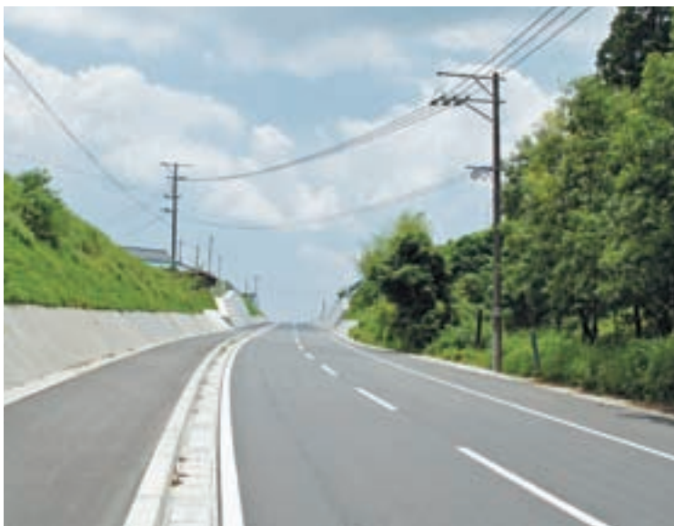
県道柿ノ木志布志線の整備完了部分
