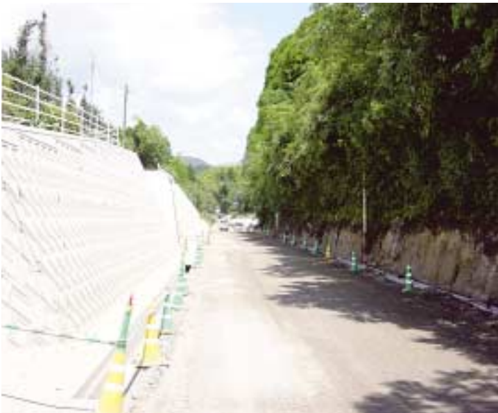
整備中の県道柿ノ木志布志線
