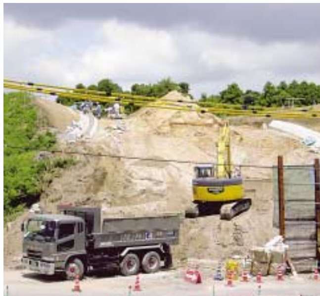
整備進む地域高規格道路 有明IC～志布志IC間
