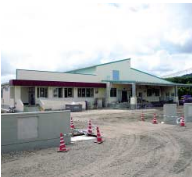
完成間近の新給食センター
