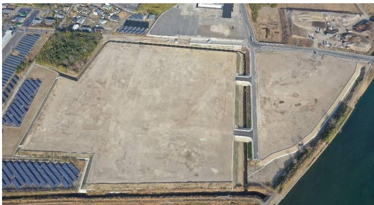
【志布志市臨海工業団地(5工区) 航空写真 [ 出典 : 志布志市 ] 】
