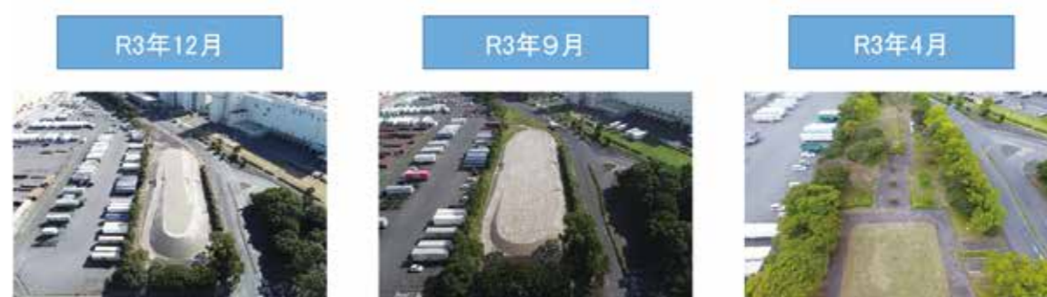
▲若浜地区築山高台整備推移
