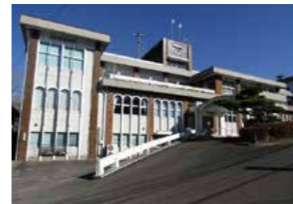
▲志布志市役所松山支所
