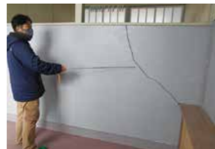
▲ひび割れの測定
