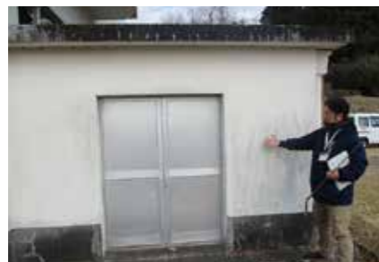
▲劣化度調査の様子
