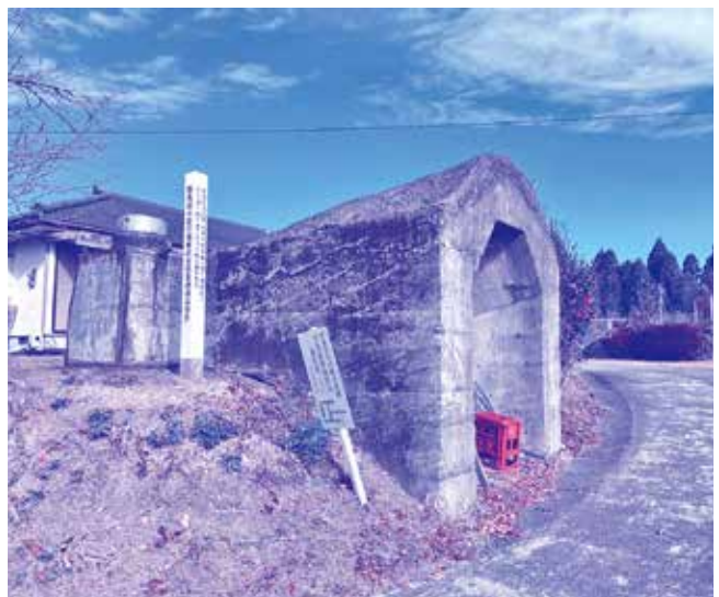
松山町新橋地区にある海軍岩川航空基地の通信壕跡、通信司令部跡
