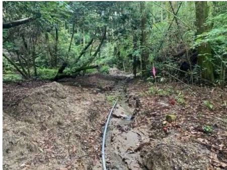
土水路の改修
