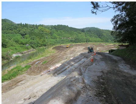
施工中のほ場
