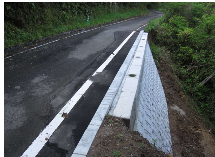
林道災害 復旧完了
