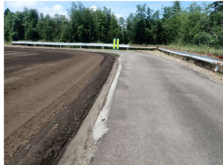
水路を新設し路面水の侵入防止を図る
