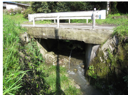
橋梁補修箇所
