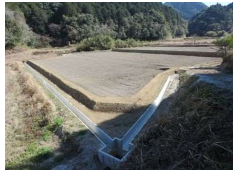
工事が完了したほ場
