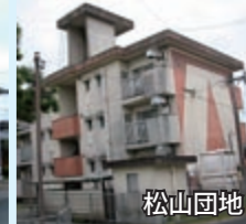
駅跡地共同住宅
