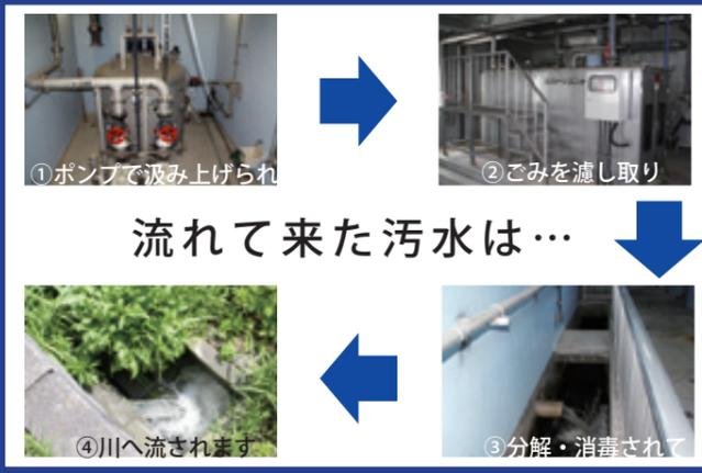
を通じて処理場に集められます。次にポンプで汲み上げられ、流量調整槽に入れられたあと、スクリーンと呼ばれる機械に汚水を通して、回分槽に入れます。そして、回分槽で空気を入れながら攪拌し、微生物の力を利用してきれいな水に分解したあと、最後に消毒されて川や海に放流します。ここまでの処理にかかる時間は6時間。これを志布志市が業務を委託している大隅衛生志布志の管理のもと、一日4回24時間コンピュータ制御で絶えず稼働しています。
