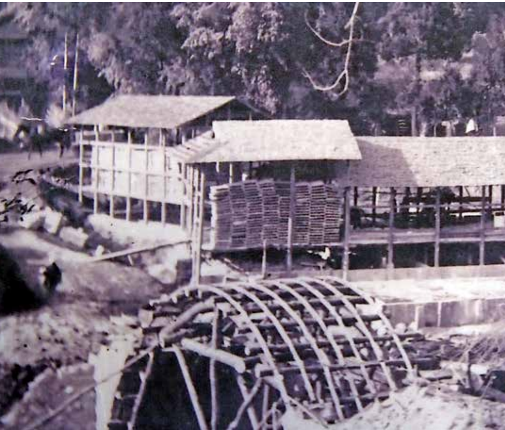
工事途中の石橋の様子（松山町第二古渡橋、昭和15年架橋）
