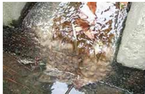
※生活排水未処理地域の側溝
