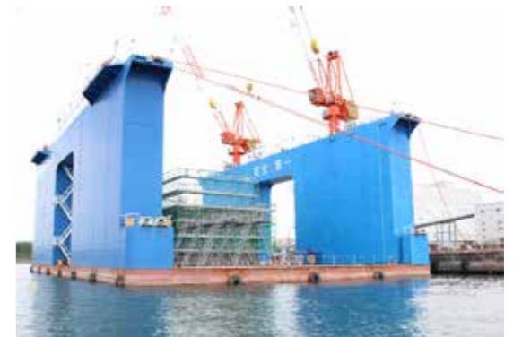
ケーソンは専用の船の上で製作されています
