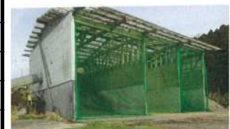
野生動物侵入防止対策 (防護柵及び防鳥ネット設置)
