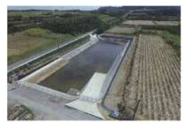
沈砂池の施工
