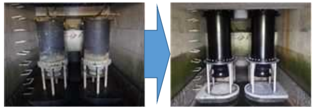
【頭首工の更新・補修】
